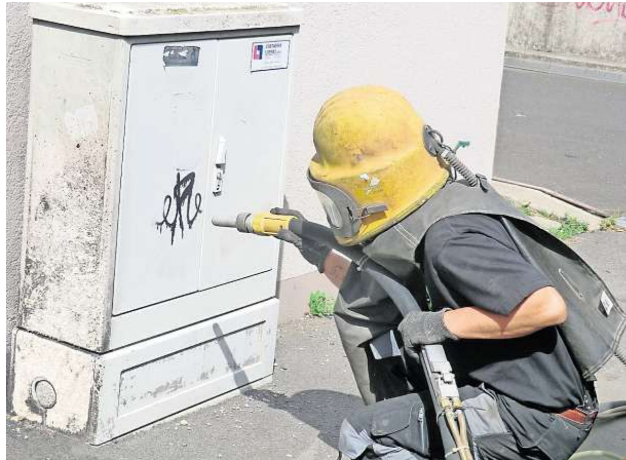
Mit Wirbelstrahltechnik werden an Stromkästen Graffiti beseitigt.
